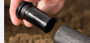
Die ISIFLO Dichthülse im Rohrende (bis zum Anschlag) einschieben. Keine Gleitmittel verwenden!
