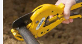
Kunststoffrohr rechtwinklig abschneiden und entgraten.
