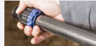
Das Rohr mit der ISIFLO Dichthülse gemäß Montageanleitung des Fittings installieren.
