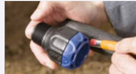
Die Einstecktiefe des Fittings am Rohr markieren.
